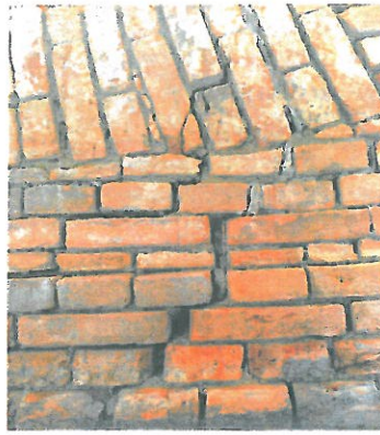
Zdj.3 Skuty i tynk i oczyszczone spoiny
